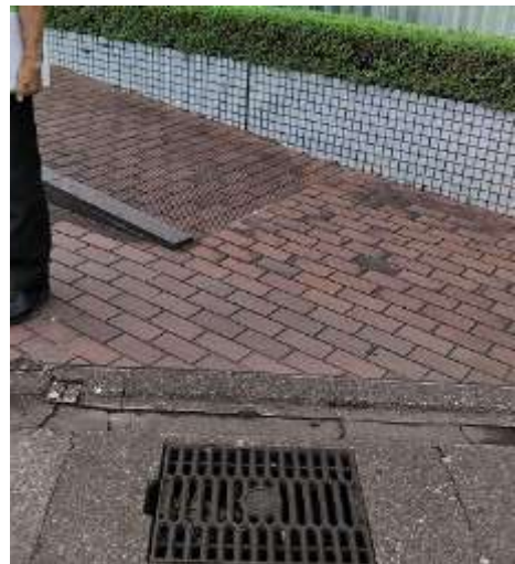
三十三銀行前:銀行のスロープ近くのグレーチングの網目が粗い。
