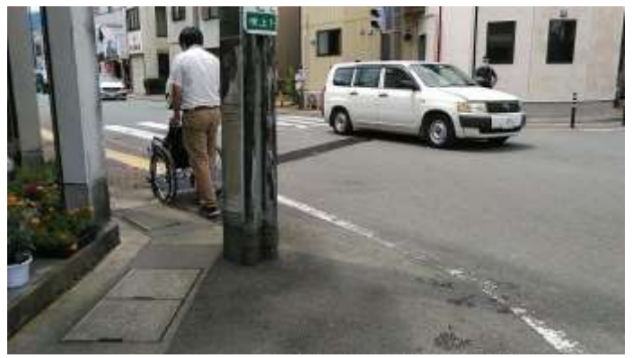
吹上交差点:通行真ん中にある電柱が視覚障害者に危険。吹上交差点から現れる誘導ブロック。反対側からだと途切れる誘導ブロック。
