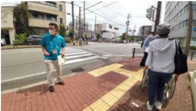
みずほ銀行前:歩道と車道の高低差あり、車いすが通りにくい。グレーチングの網目が粗いのも気になる。
