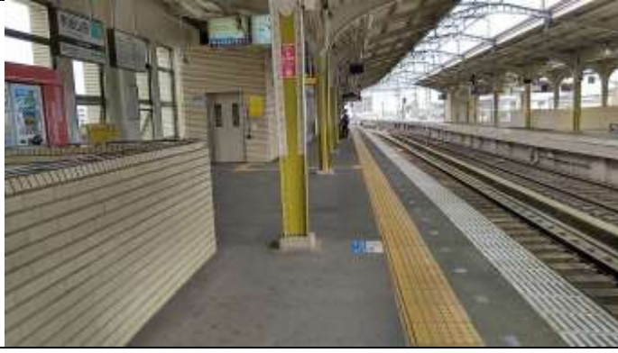
宇治山田駅:階段壁と柱の間は、60cm未満で車いすの通行はできない。せめてこの幅が車いす通行できる幅があると、安心してホームを通行できる。
