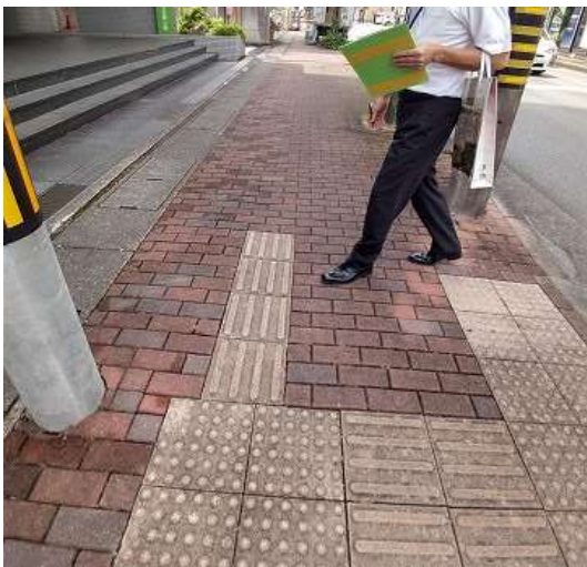
三十三銀行前:誘導ブロックの途切れ、中途半端の誘導ブロックはなくしたほうがいい。
