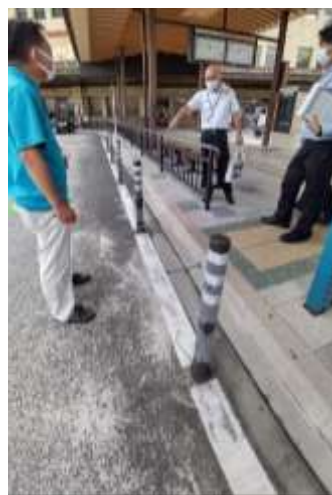
宇治山田駅バス停:段差 15cm。低床バスがギリギリに幅寄せすれば、段差なしやスロープの傾斜なく乗車できるが、歩道から離れてバスが停車すると、15cmの段差を降りなければならない。ポールの意図は？←確認
