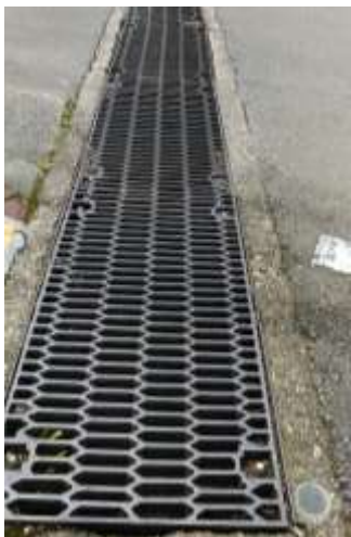
吹上交差点:横断歩道に平行にあるグレーチングの目が粗い
