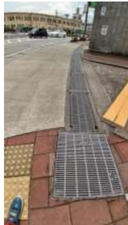
響ホールの駐車場入り口:グレーチングの網目は細いものの、車道への傾斜もあり、車いすでは通行しにくい。車の往来で危険度もあり。ちなみに響ホールへ上がるエレベータがこの先にある(正面入り口に案内表記が欲しい)ため、駅から来るとここは必ず通る。
