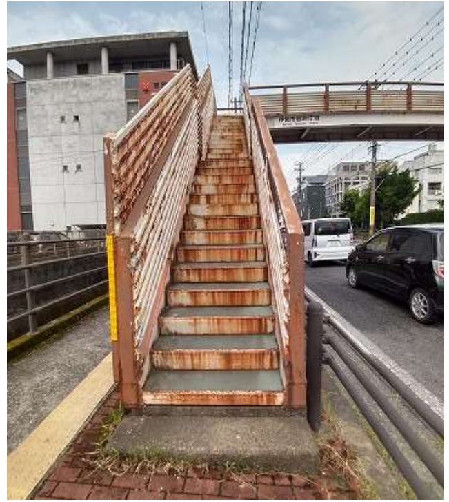
歩道橋:需要(利用度)を調査して、必要性を確認しては？
