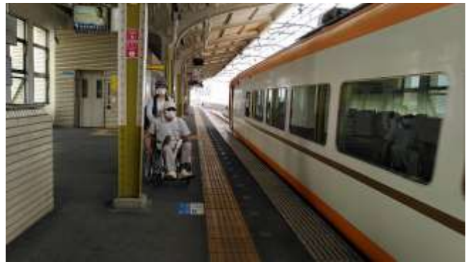
宇治山田駅:ホーム上の柱を避けると、線路側を通ることになる。点字ブロックを踏むことになり、傾斜も線路側に傾いているため、車いすは恐怖を感じる。
