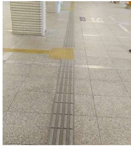
宇治山田駅:ホーム上の柱を避けると、線路側を通ることになる。点字ブロックを踏むことになり、傾斜も線路側に傾いているため、車いすは恐怖を感じる。
