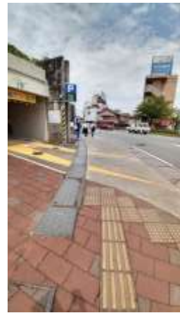
響ホールの駐車場入り口:グレーチングの網目は細いものの、車道への傾斜もあり、車いすでは通行しにくい。車の往来で危険度もあり。ちなみに響ホールへ上がるエレベータがこの先にある(正面入り口に案内表記が欲しい)ため、駅から来るとここは必ず通る。
